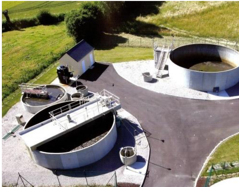
Figure 6 : Exemple de station d'épuration à boues activées
