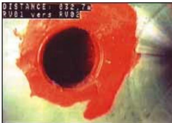
Robot de réhabilitation des branchements à l'intérieur Inspection d'un branchement après intervention
